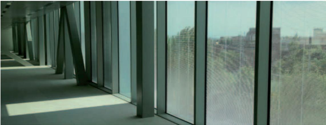
Das Bauvorhaben besteht aus mehr als 400 Verglasungsmodulen mit integrierten ScreenLine®-Behängen mit einer Höhe von bis zu 4,2 m. Die Module wurden in der Südwest-Fassade verbaut, die einer starken Solarstrahlung ausgesetzt ist.
